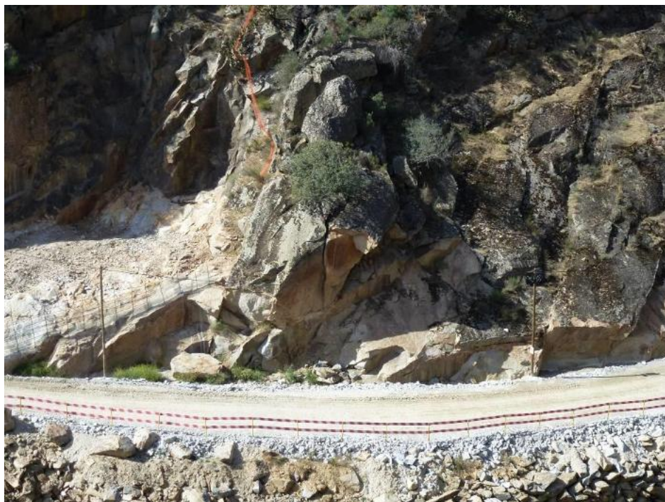
Fotografia 2 – Bloco rochoso pendendo sobre a estrada por onde circulam as máquinas da obra; fotografia tirada na margem esquerda do rio Tua a jusante da zona onde está a ser implantada a barragem (abril/2012)
